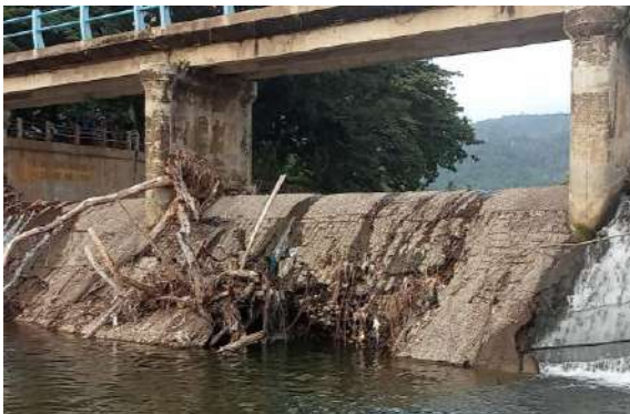
Gambar 1. Kerusakan Selimut Beton Bendung Daerah Irigasi Koto Kandis (Sumber : Observasi Balitbang Prov. Sumbar, 2023)
